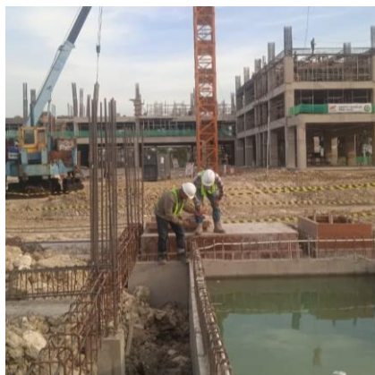
Gambar 6 Pelaksanaan Pengisian Air pada Kolam Area Kolam Renang (Sumber: Dokumen Proyek)
