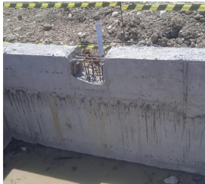
Gambar 3 Pemasangan Sistem Kolam Renang Villa (Sumber: Dokumen Proyek)
