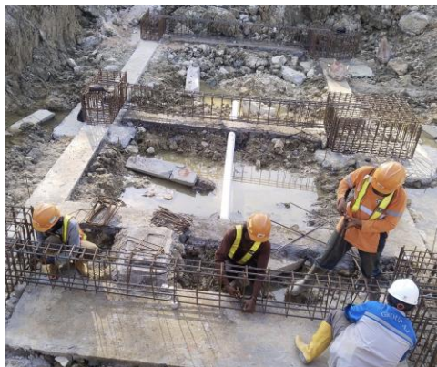
Gambar 1 Pelaksanaan Pemasangan Pembesian Struktur Kolam Renang (Sumber: Dokumen Proyek)
