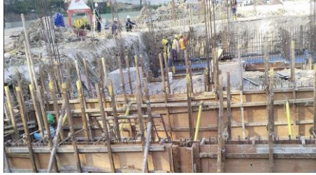
Gambar 2 Pelaksanaan Pemasangan Bekisting Kolam Renang (Sumber: Dokumen Proyek)
