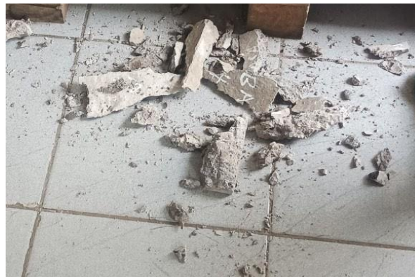
Gambar 5. Kerusakan Pada Sampel Beton Basa
