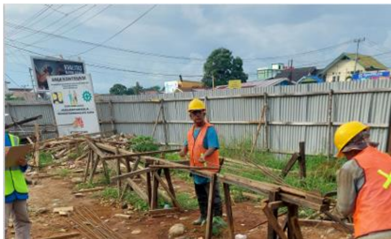
Gambar 6. Memberikan Kuisioner kepada Tukang (Pemasangan Pabrikasi Besi)
