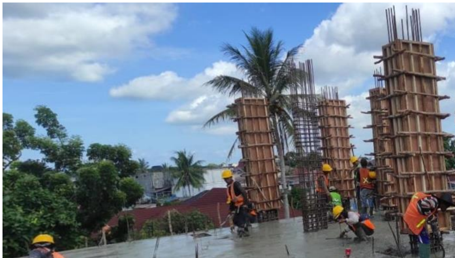
Gambar 8. Dokumentasi Kegiatan pengecoran
