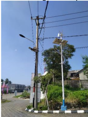
Gambar 3.2 Panel surya dan turbin angin
